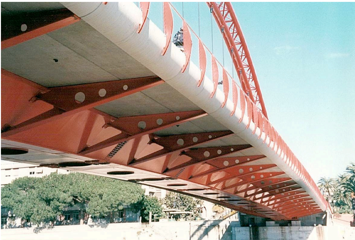
Vista dell'intradosso del ponte
