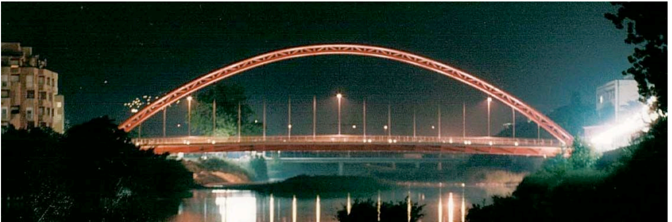
Vista notturna del ponte
